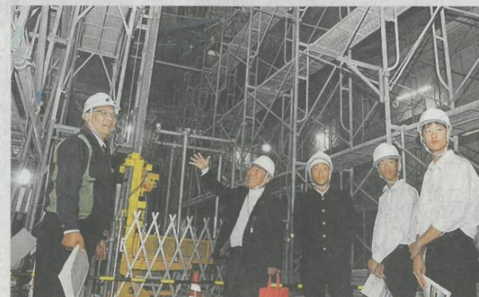
建設中の「IYO夢みらい館」を見学する高校生ら
